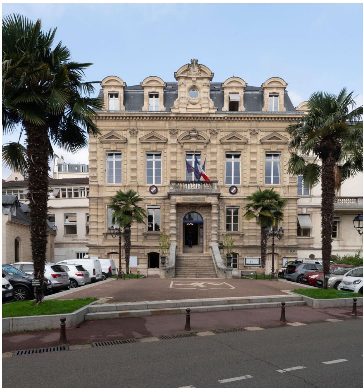
Mairie, façade principale
