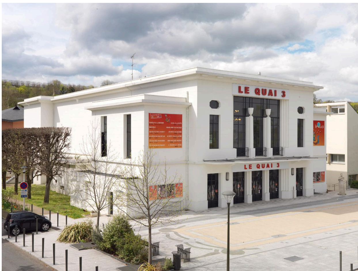
Vue générale du bâtiment
