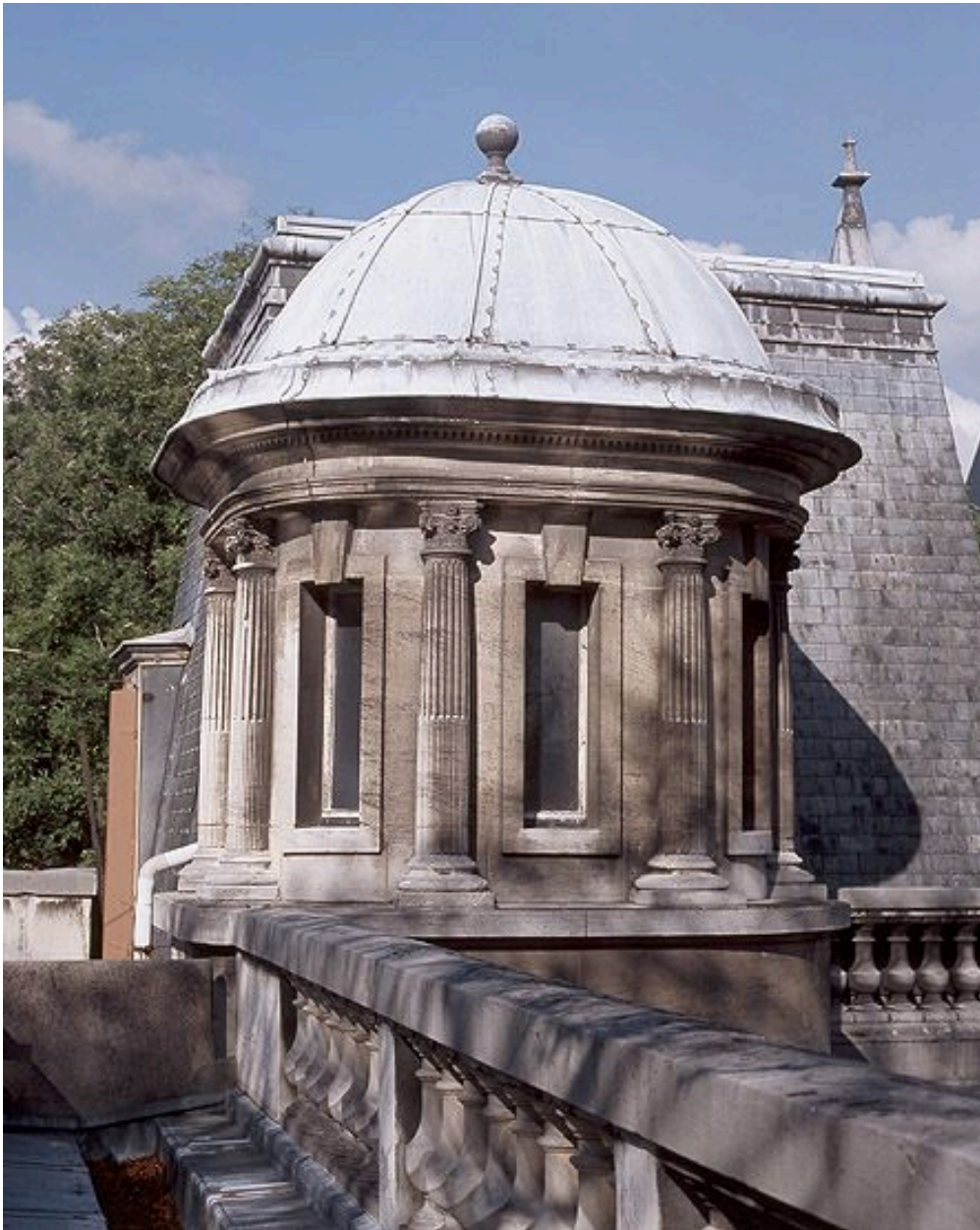
Détail de la petite rotonde sur le toit de la bibliothèque.
