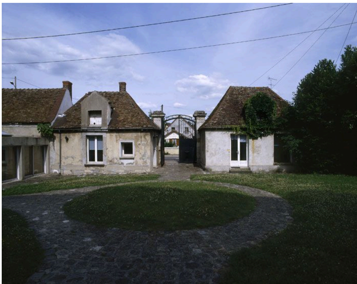
Les deux pavillons d'entrée.
