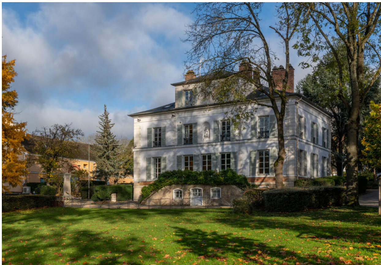
Vue de trois-quart des façades sud et est.
