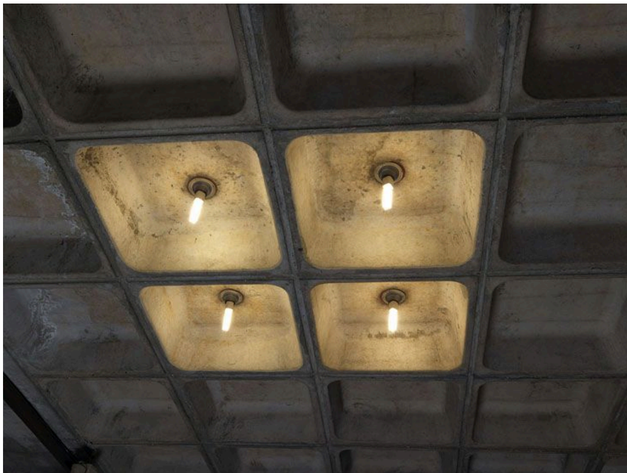
Détail des éclairages intégrés aux plafonds à caissons de béton moulé.
