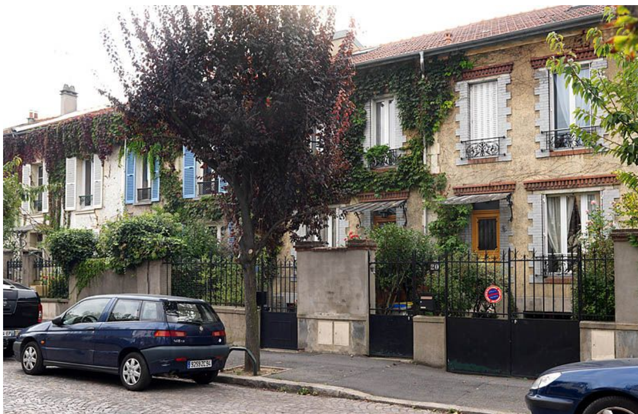
Choisy-le-Roi, lotissement concerté, 16, 18, 20, 22 rue Mirabeau. Vue d'ensemble.
