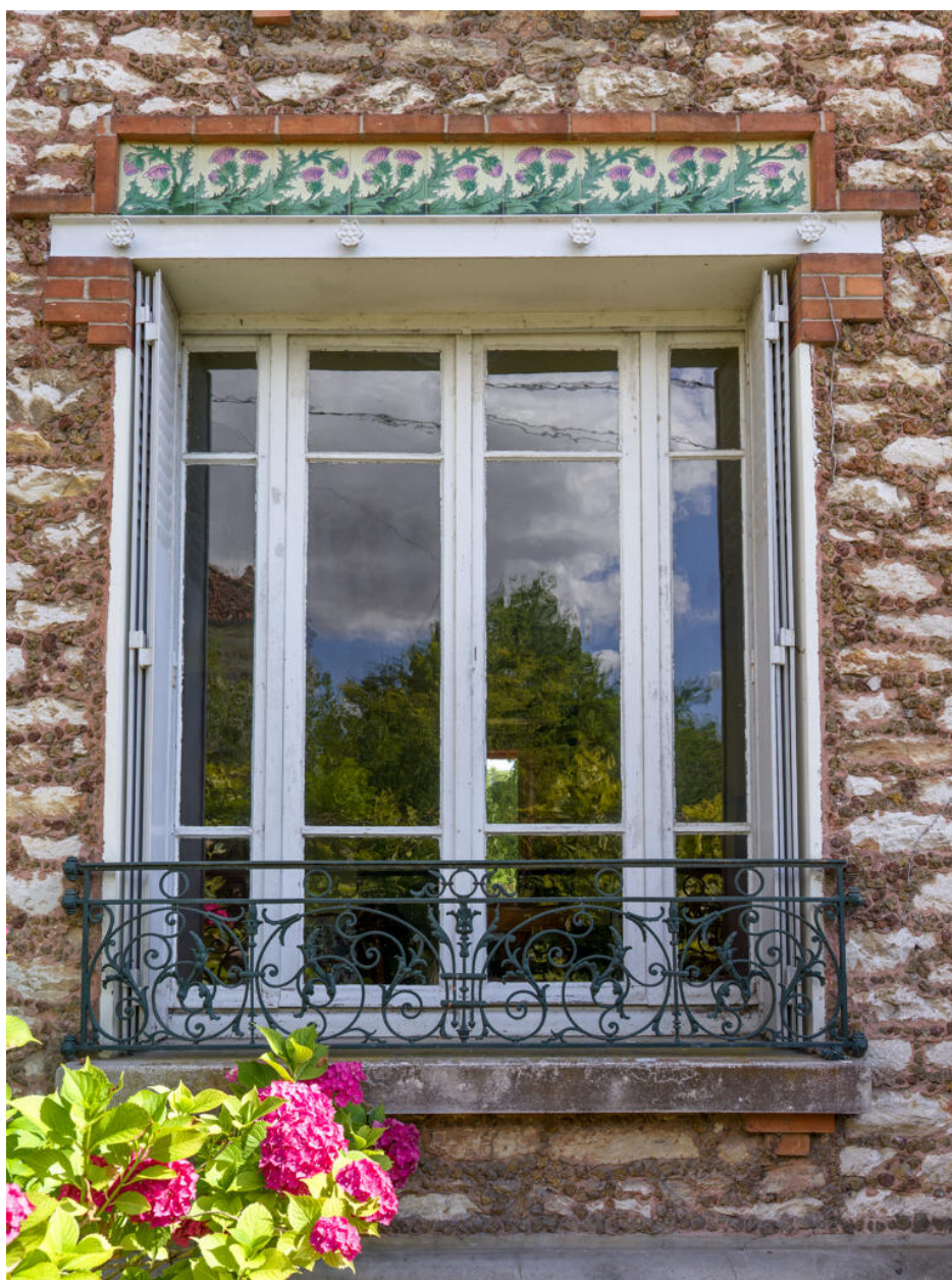
Baie du rez-de-chaussée du 25 rue Saint-Pierre.
