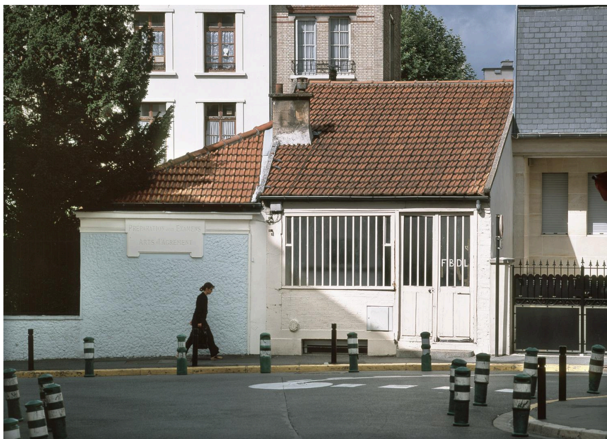
Vue de l'atelier depuis la rue Jean-Moulin.
