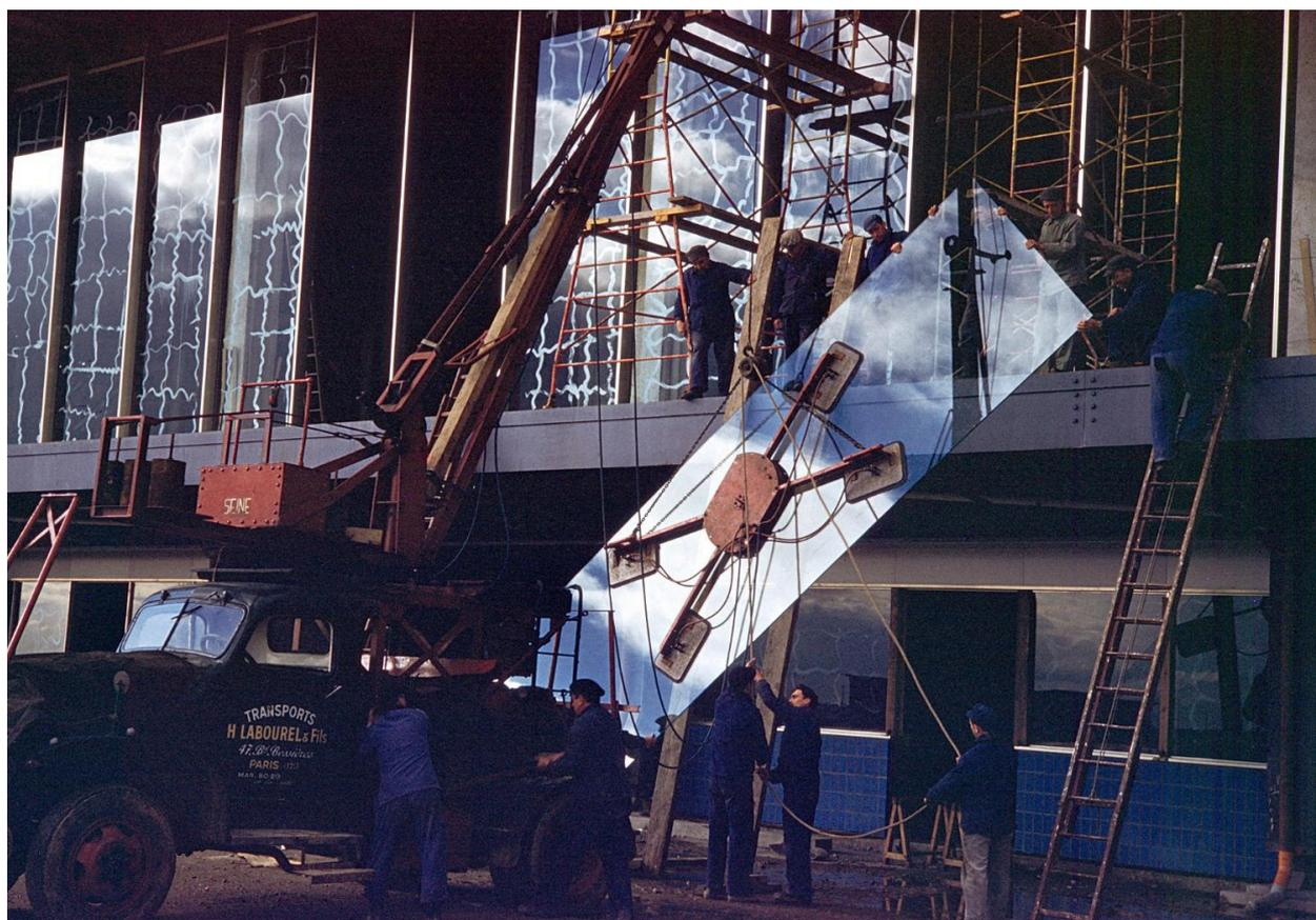
1957 1961, la construction des Installations Terminales: l'installation des dalles en verre du mur-rideau de la façade sud, vue prise depuis le sud est.
