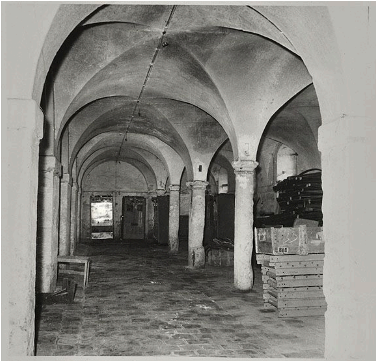
Photographie des anciens bâtiments de l'abbaye Notre-Dame du Marché, reconvertie en quartier de cavalerie, avant démolition : vue intérieure de la salle capitulaire. Photographie, vers 1965. (Médiathèque Luxembourg, Meaux. Fonds Endrès )
