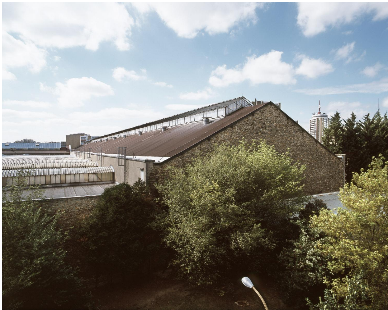
Vue du "hall nord" de remisage (début du XXe siècle).
