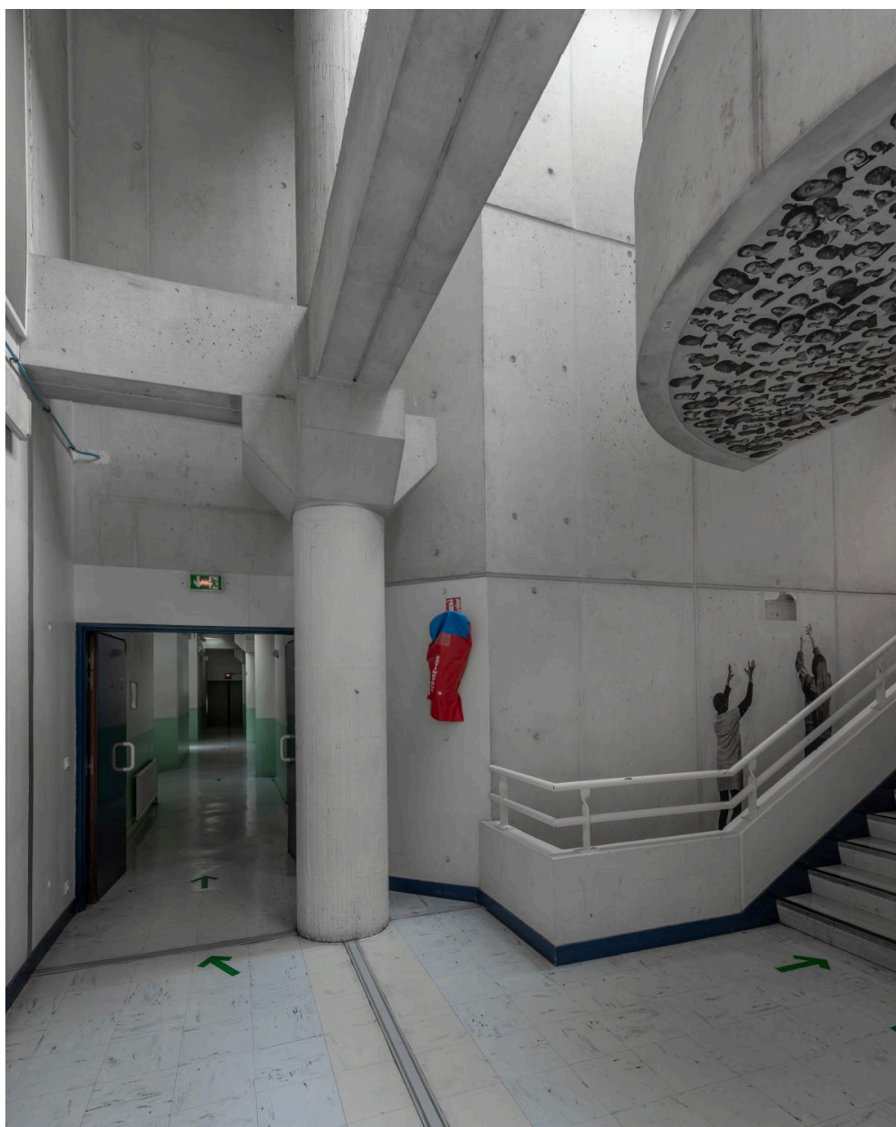
Le départ de l'escalier.
