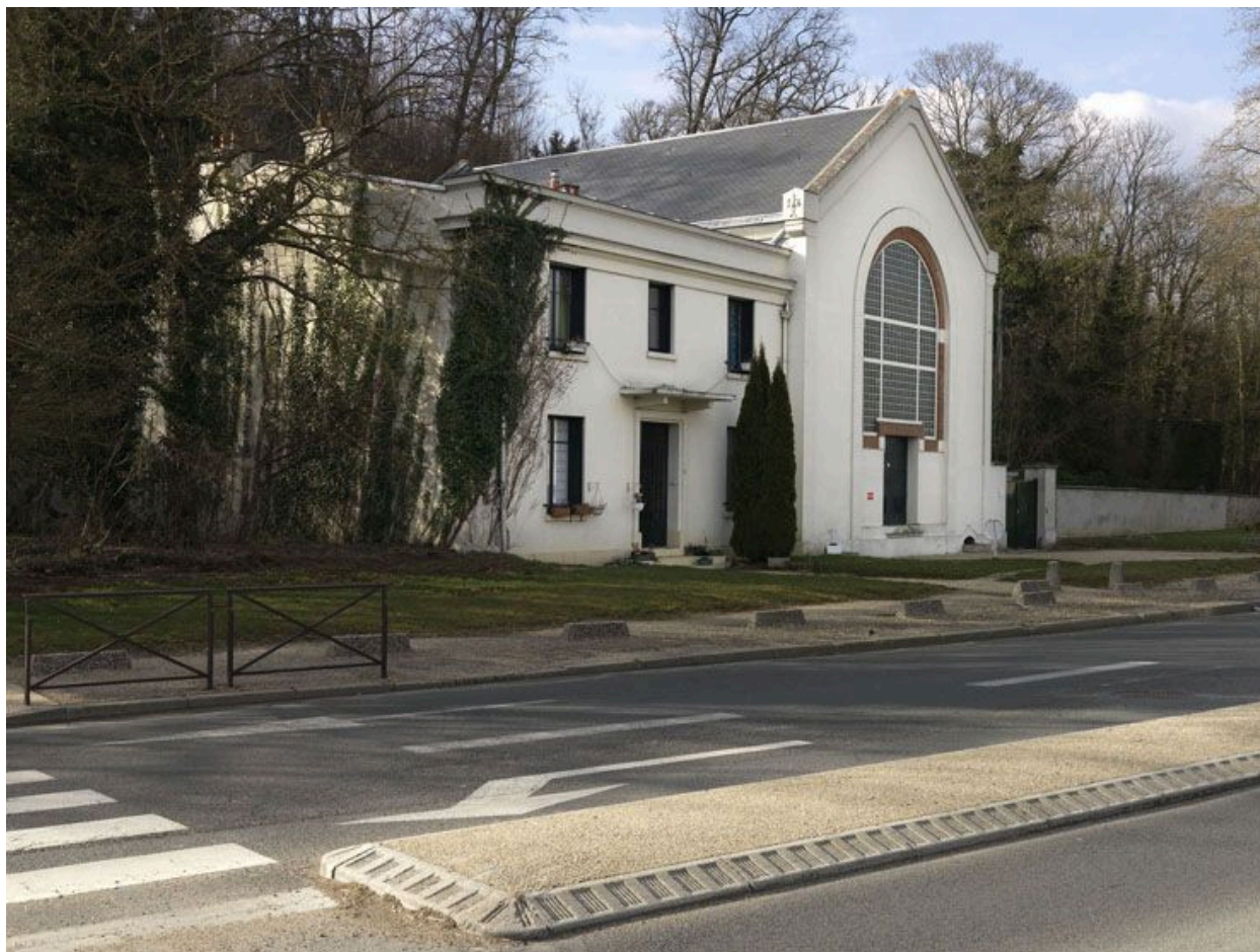
Station de pompage et logement de contremaître.
