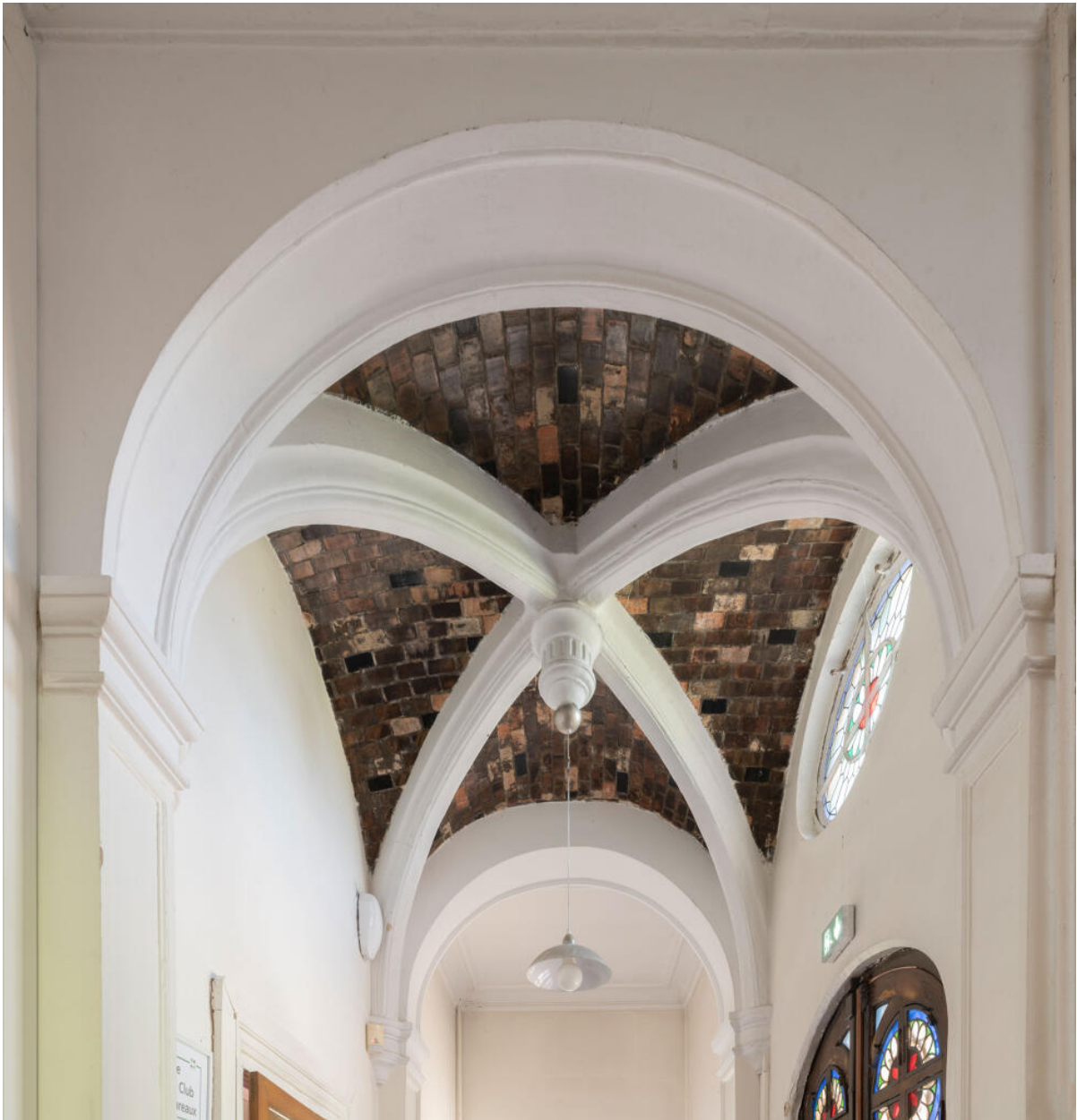
Dans le vestibule, détail de la voûte à croisée d'ogives.
