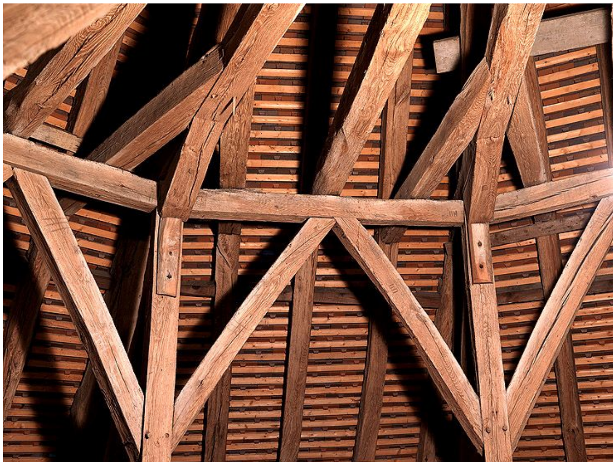
Détail de la charpente de l'abside, au niveau de la croupe.
