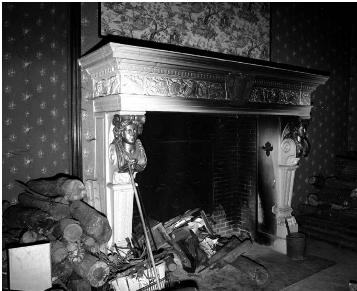
Cheminée de syle classique dans une des pièces du rez-de-chaussée. Cliché Pré-inventaire, 1974. (Région Ile-de-France, service patrimoines et inventaire, Cliché Pré-inventaire)
