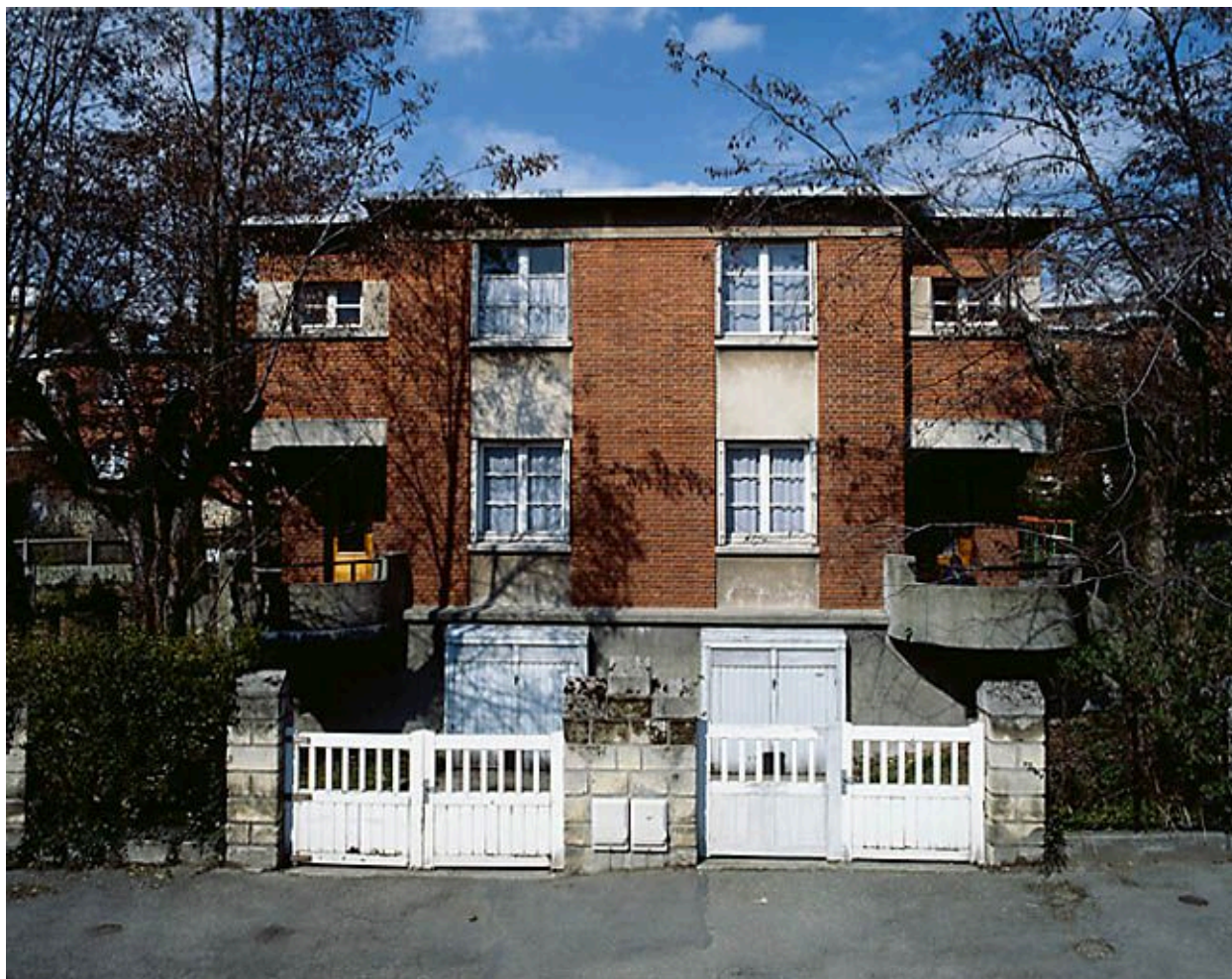
Façades antérieures de maisons jumelles, 15, 17 rue Proudhon.
