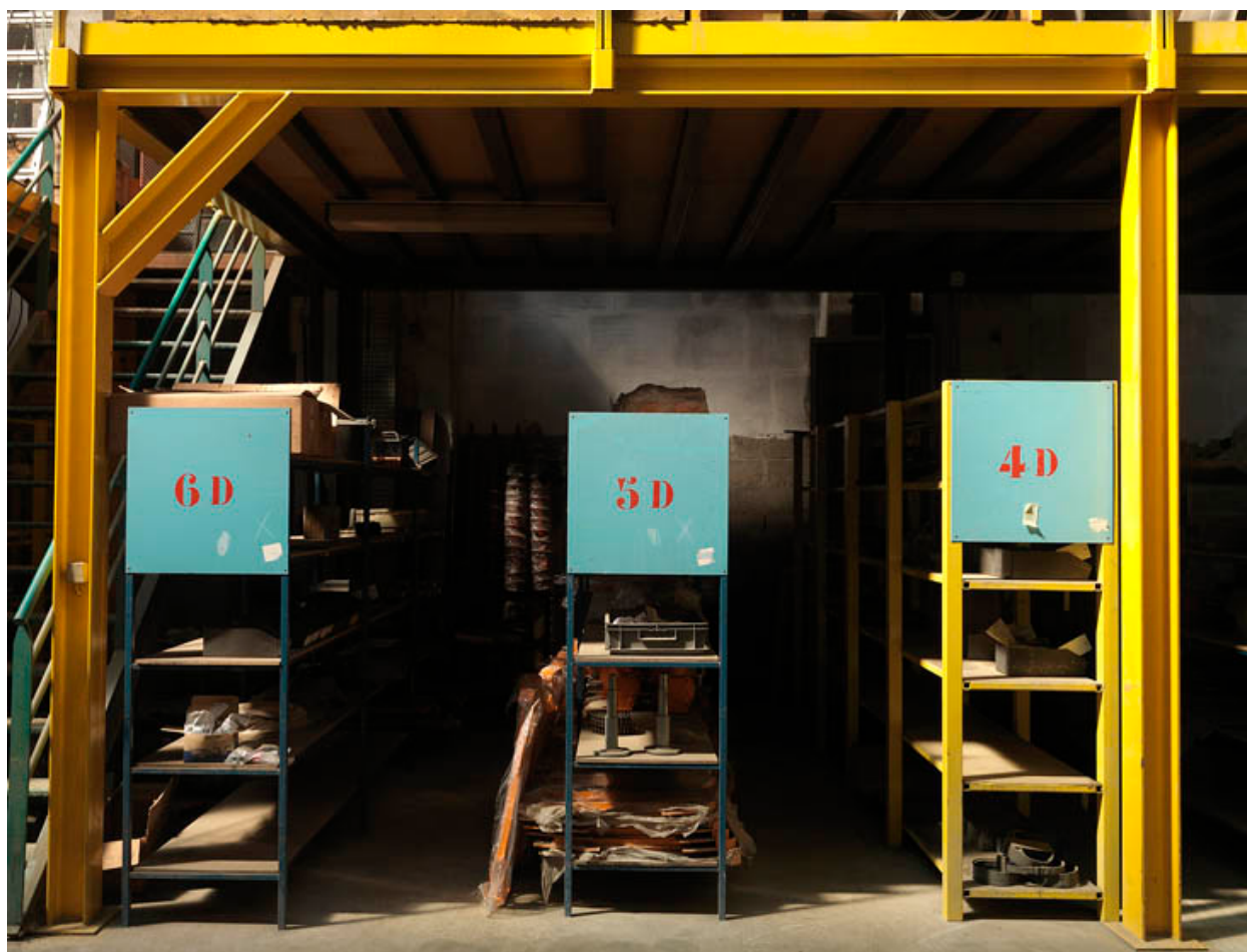
Ateliers sud, occupés par le carrossier-constructeur Mecagil-Lebon.
