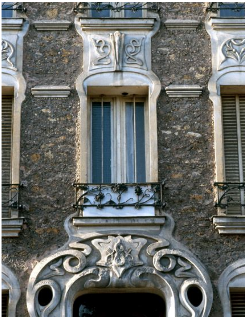
Détail d'une travée d'un immeuble, 17 avenue du Président Roosevelt.
