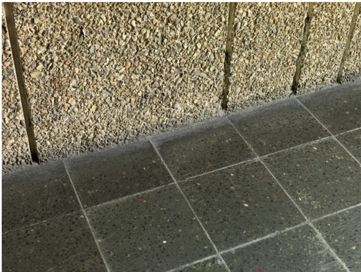
Sol en marbre et revêtement des murs en mignonnette.
