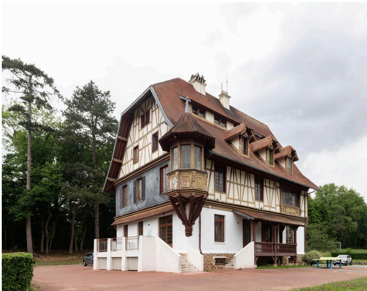
Façades sud et est
