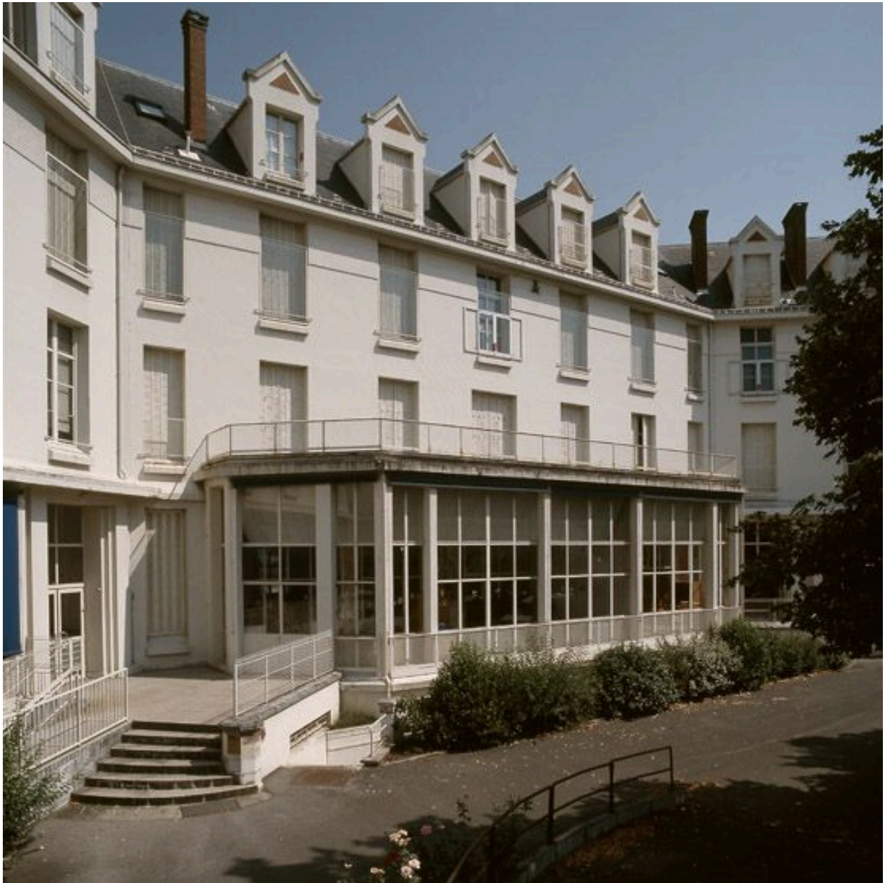
La cure d'air et sa galerie vitrée au rez-de-chaussée du bâtiment en V.
