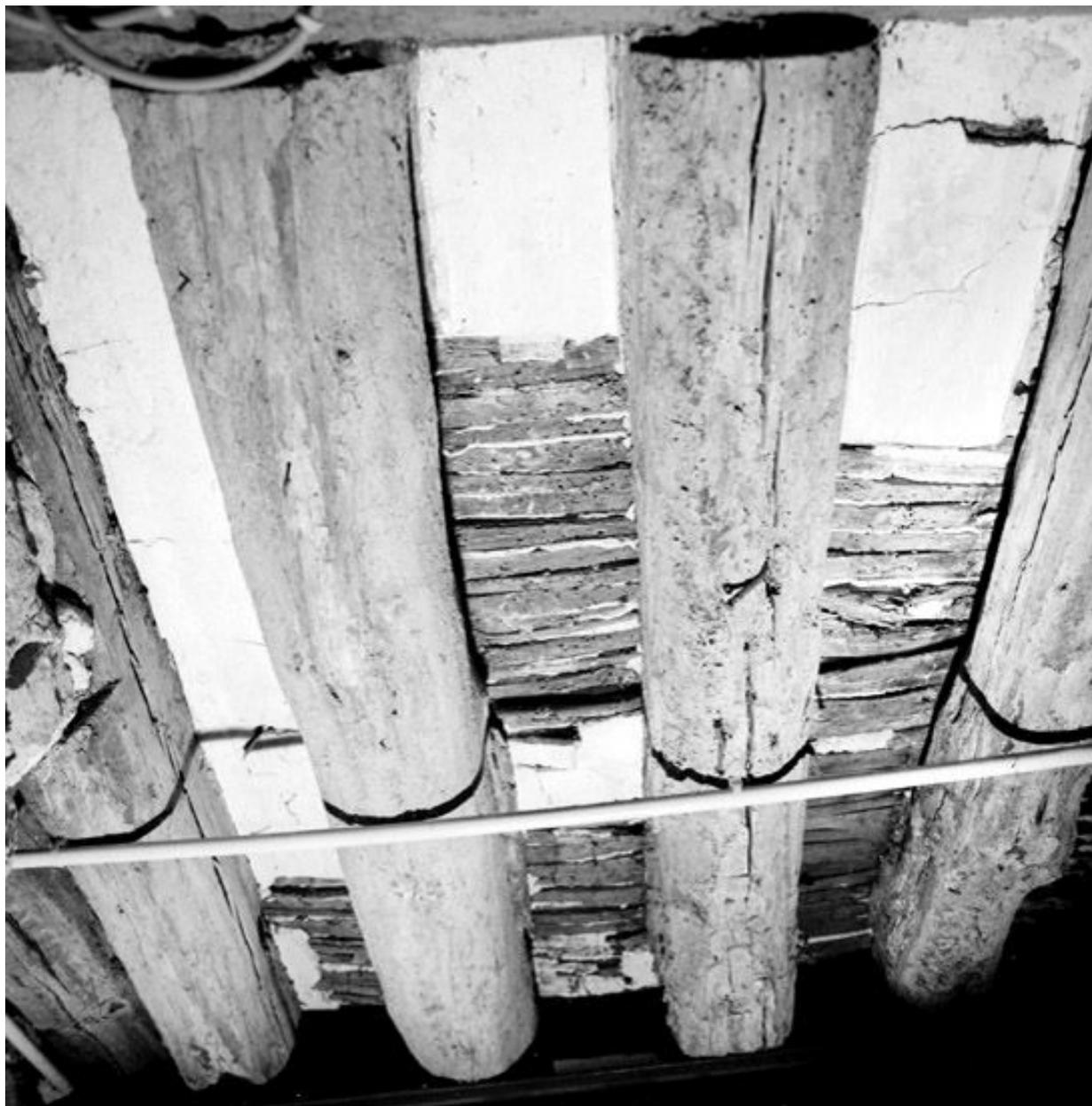
Salle en demi sous-sol, sur le côté est de la cour : détail de la mise en oeuvre du plafond.
