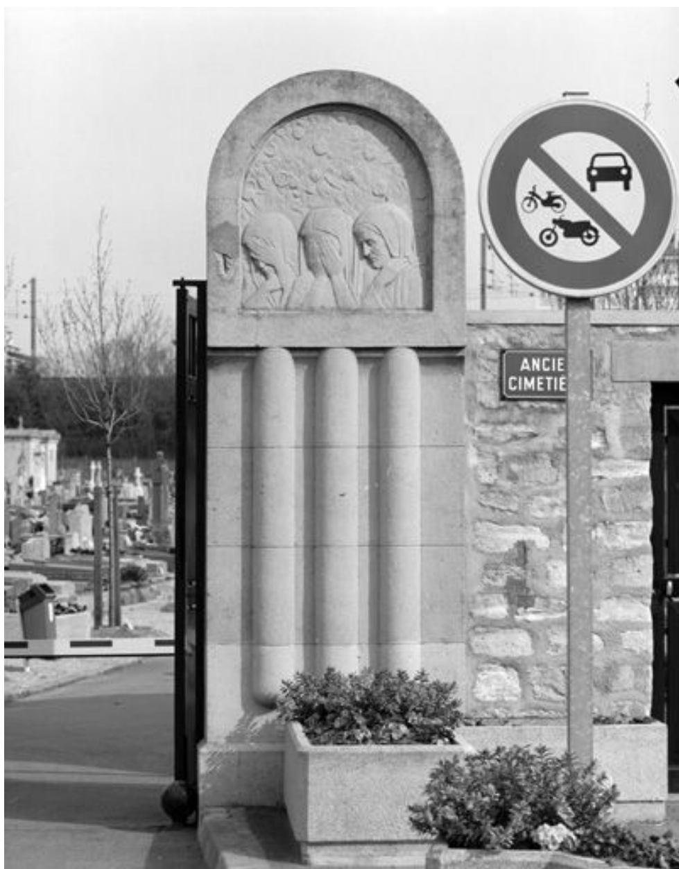
Détail du portail d'entrée du cimetière : vue du pilier droit.
