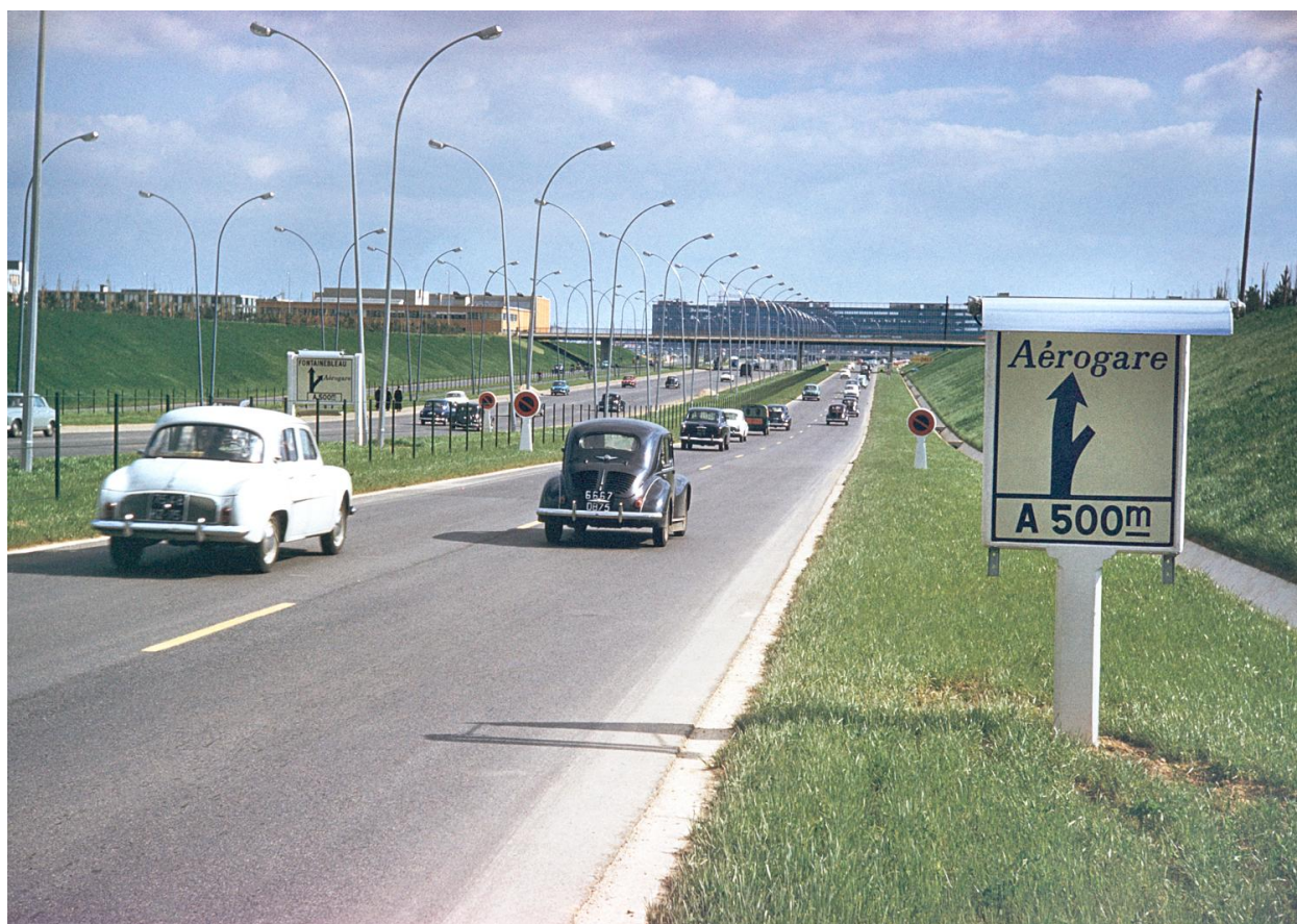
1962, les Installations terminales vues depuis le nord.
