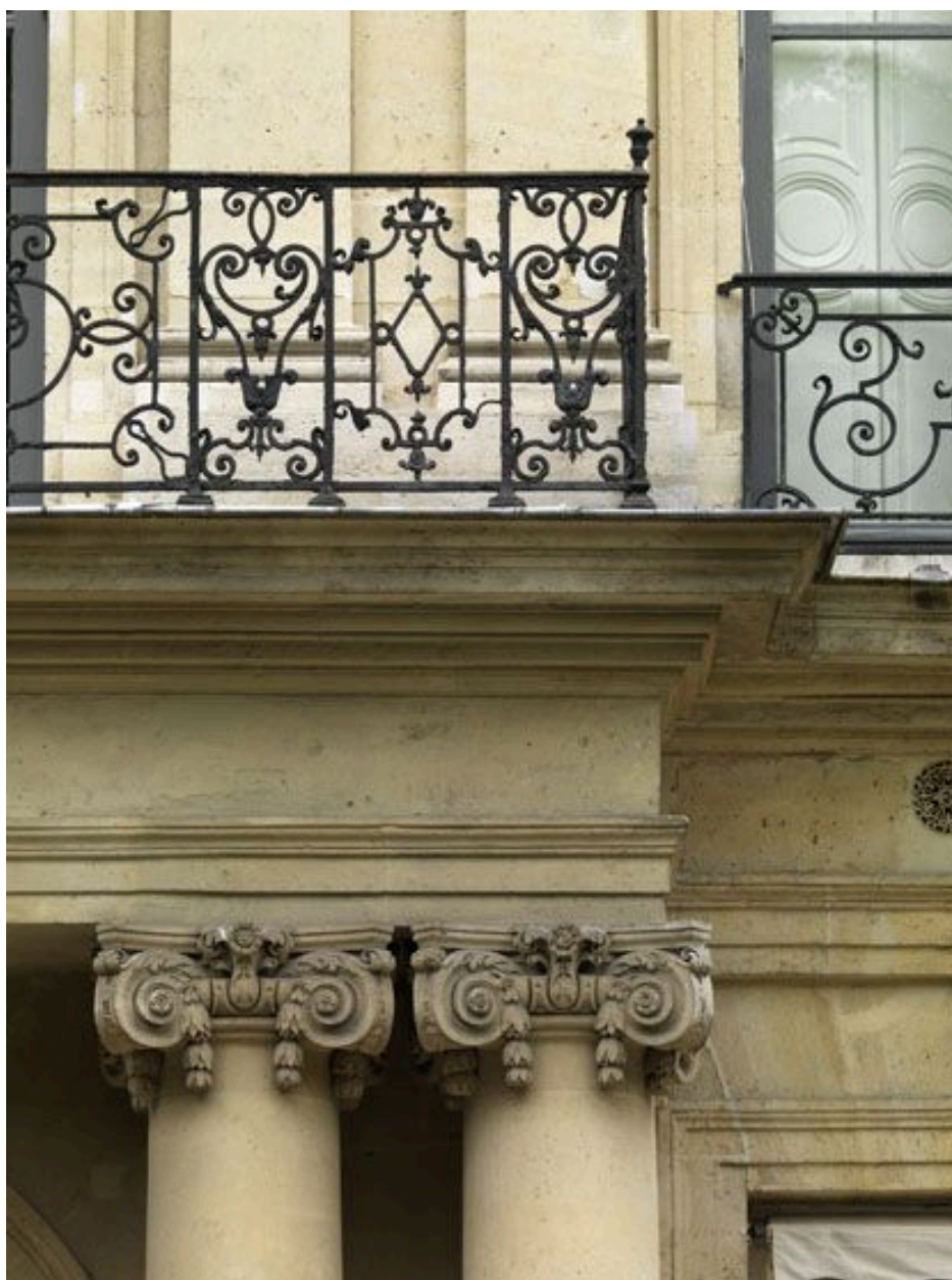
Double pilastre et panneau étroit du balcon de l'avant corps de la façade sur jardin, hôtel de Rothelin Charolais, 101, rue de Grenelle.
