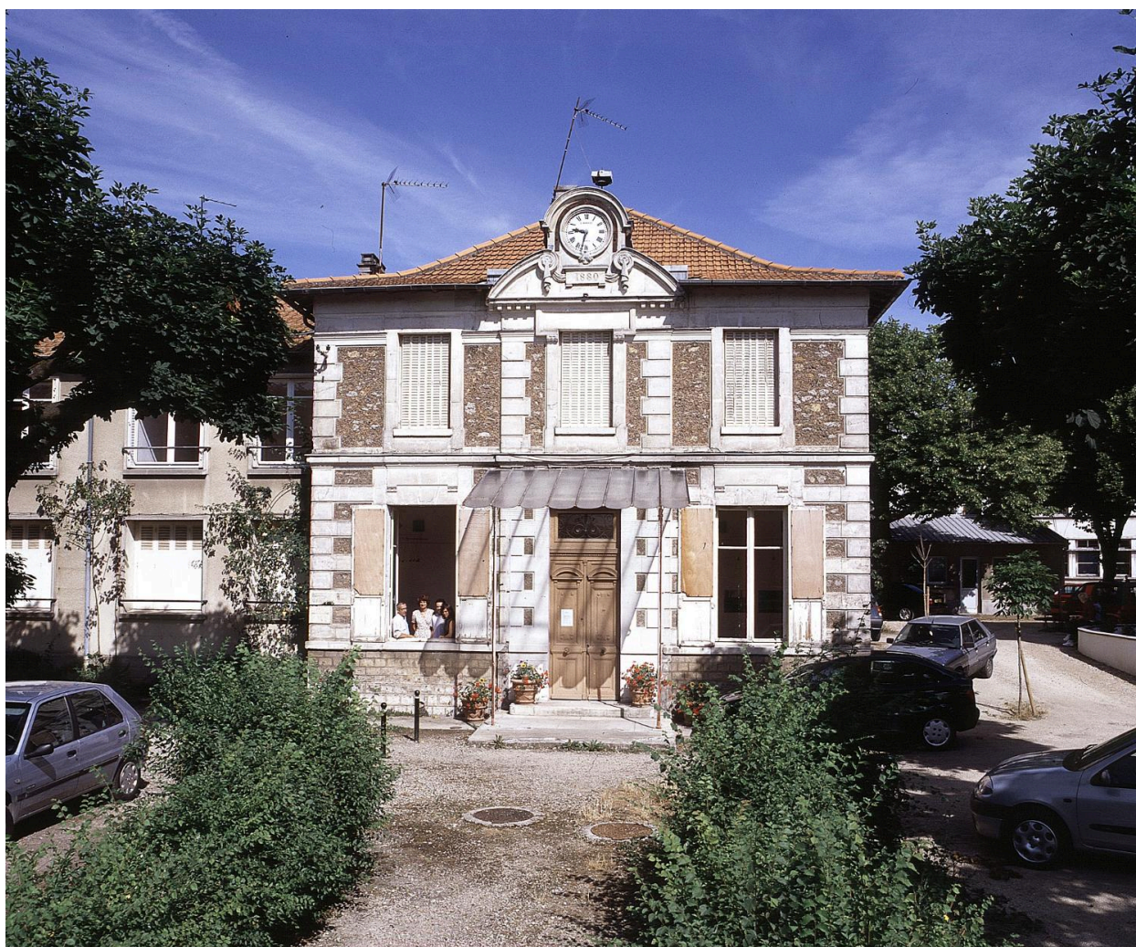
Vue d'ensemble du bâtiment, aujourd'hui siège de la Maison de Banlieue et de l'Architecture.
