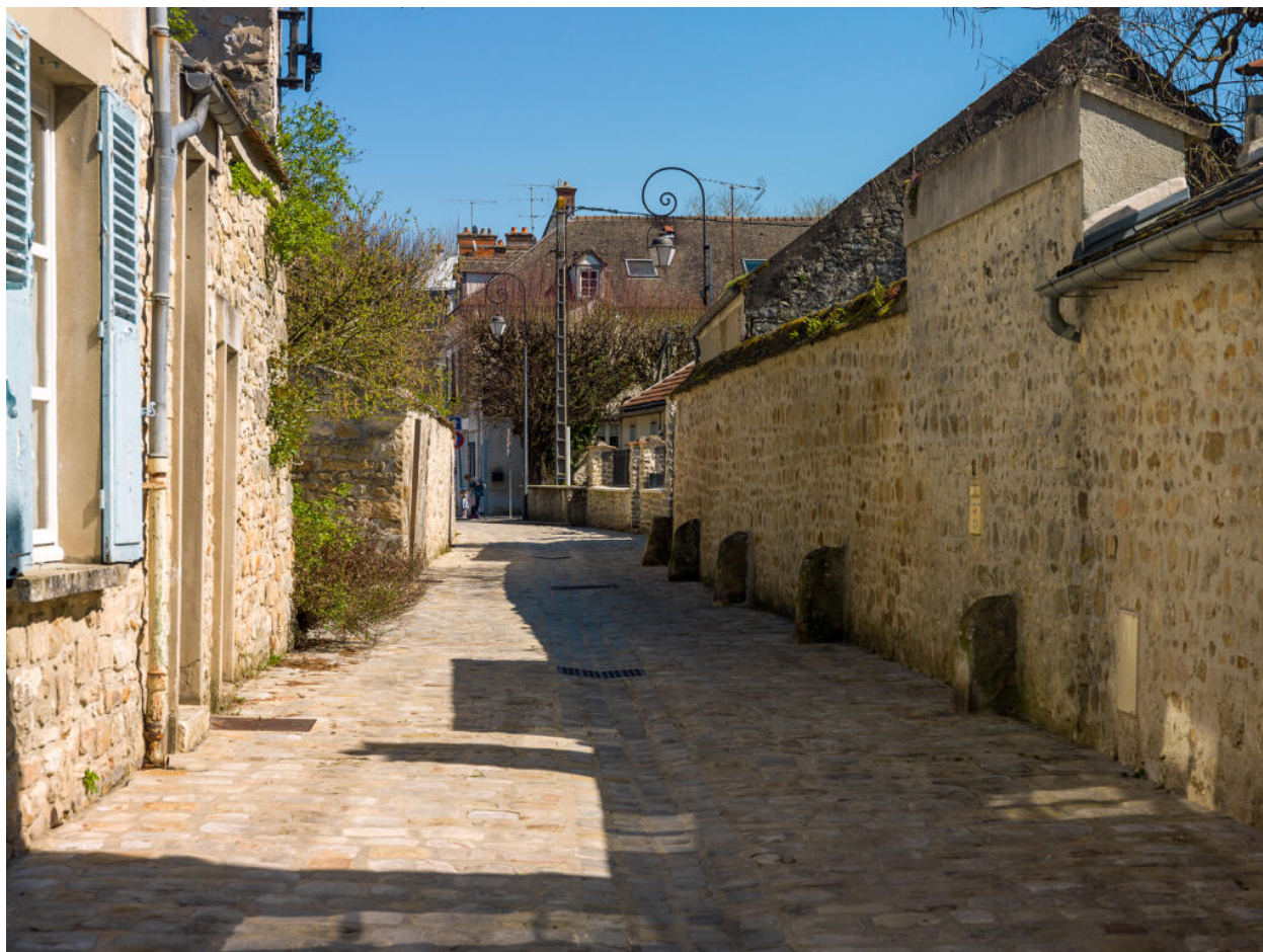
Vue générale de la rue du Lau depuis l'ouest.
