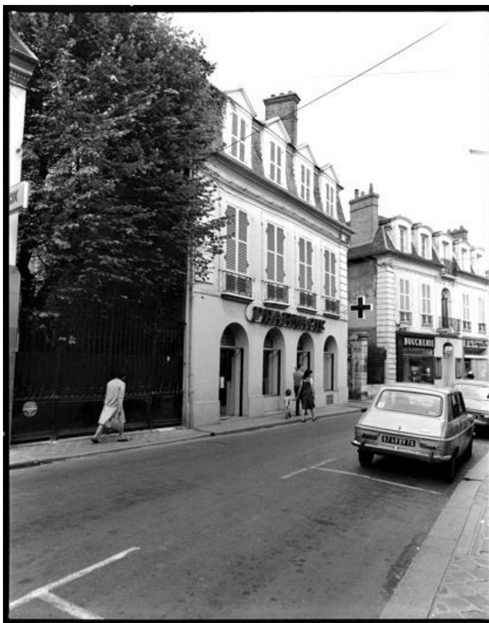
Maison, Gambetta (rue) 6. Façade sur rue.
