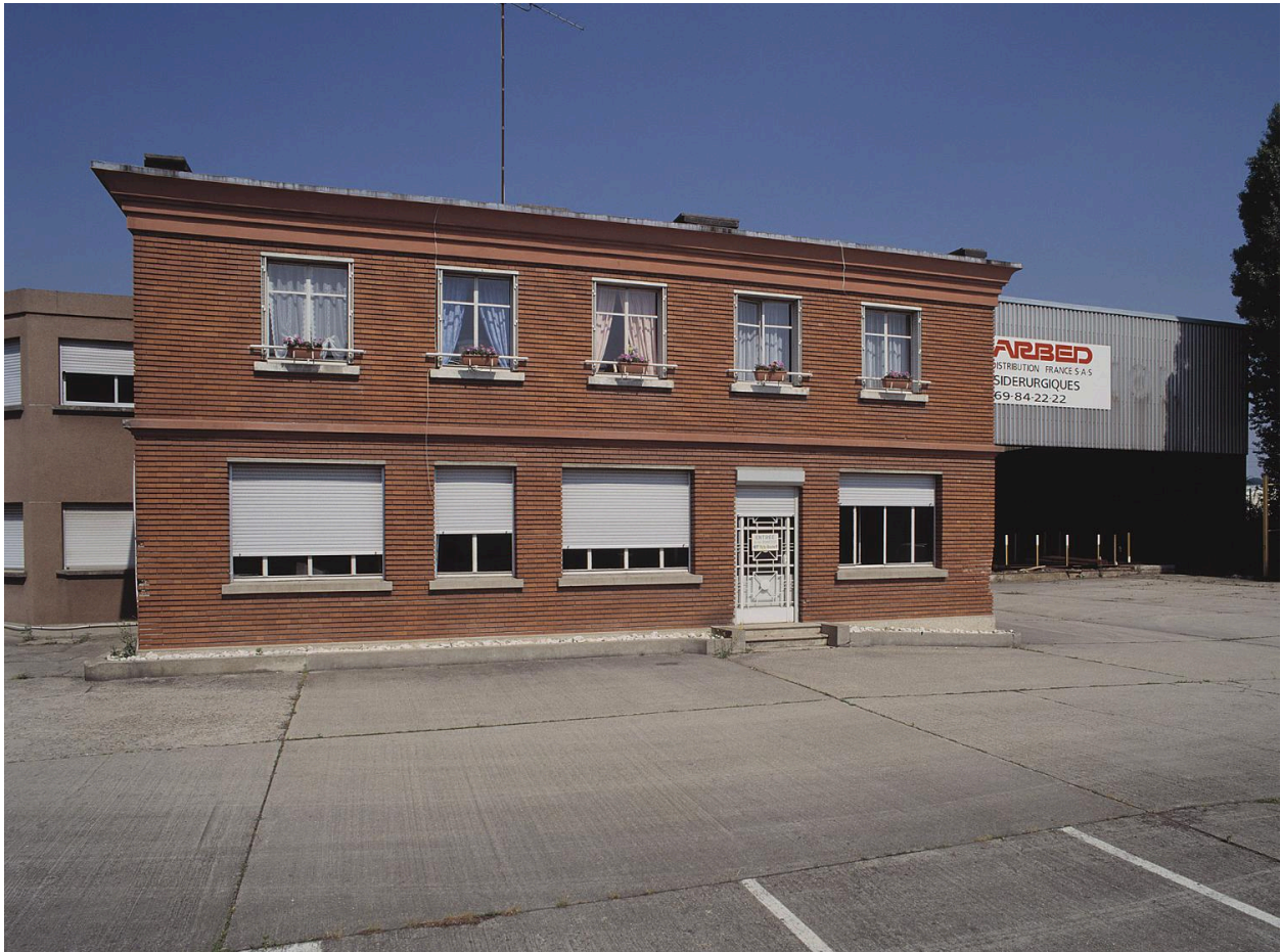
Etablissements Champion : façade antérieure du même bâtiment.
