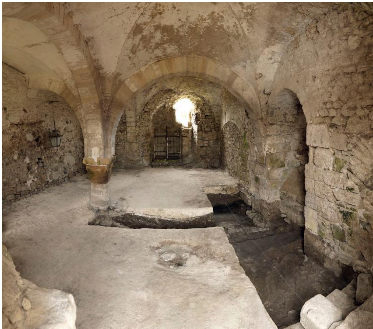
Vue sur la salle 4 (numérotation du sud vers le nord) de la grange des Beauvais depuis l'angle nord-est.
