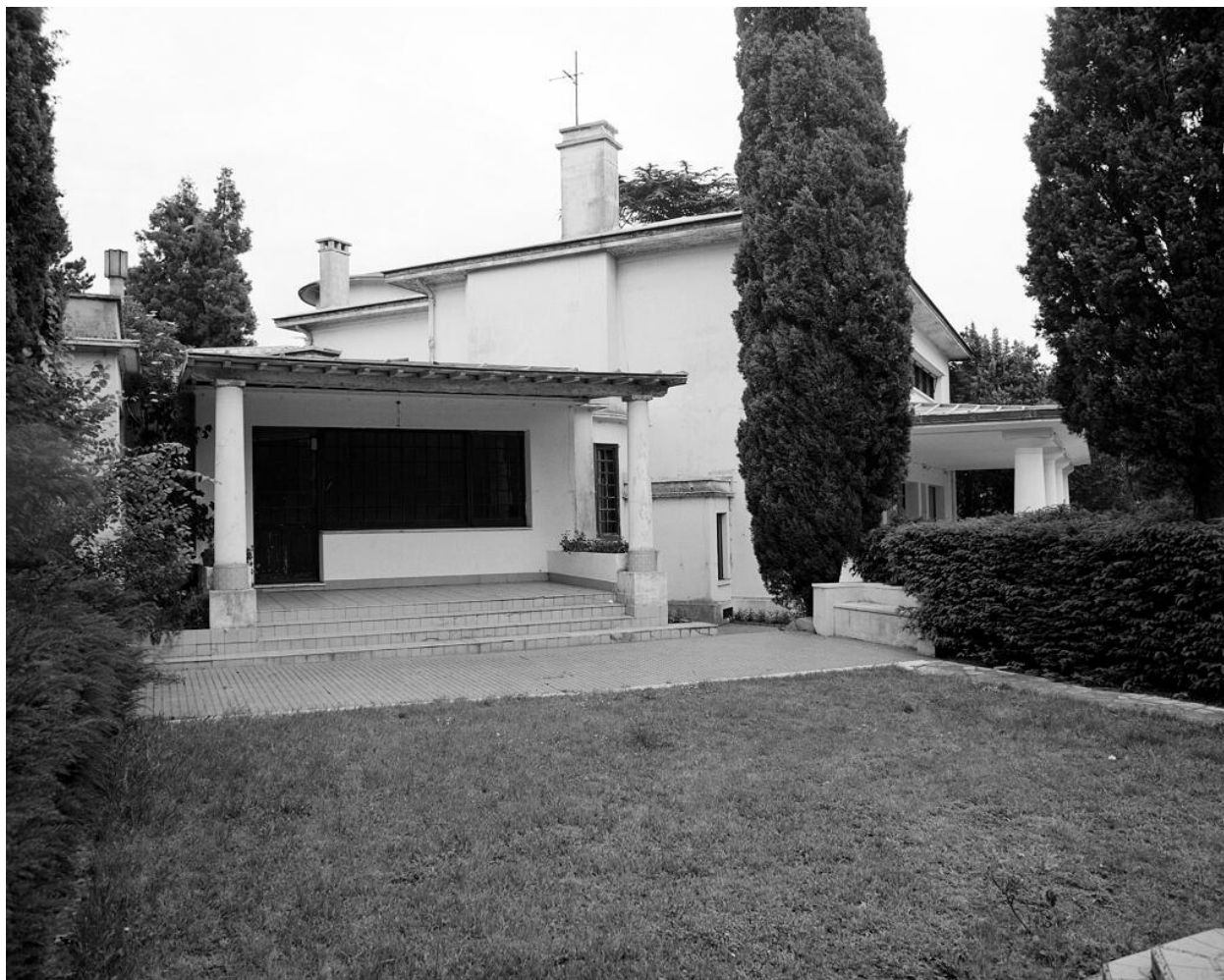
Façade sur le bassin (Sud-Ouest). Maison de maître dite le Moulin Fidel
