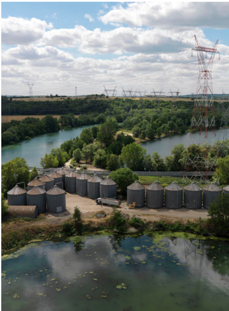
Silos de l'UNCAC Invivo de la Grande Paroisse. Silos 7 vus depuis la tour de travail du silo 6.
