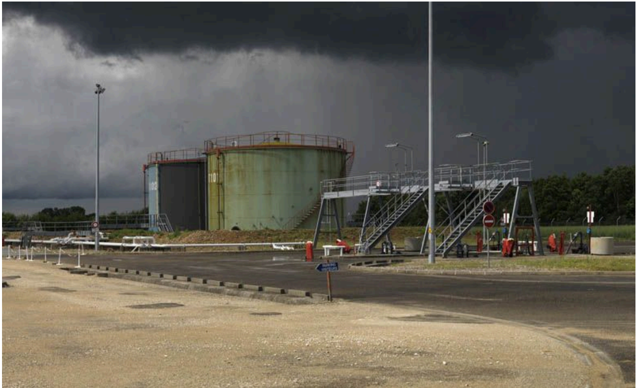
Centre de production, cuves de décantation (T101 et T102) et centre de chargement pour camions citernes.
