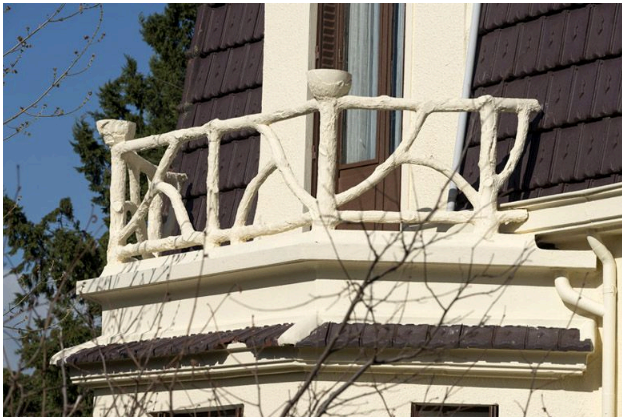
Détail d'un garde-corps en ciment qui reprend le motif du tronc d'arbre, 3, boulevard de la Plage.
