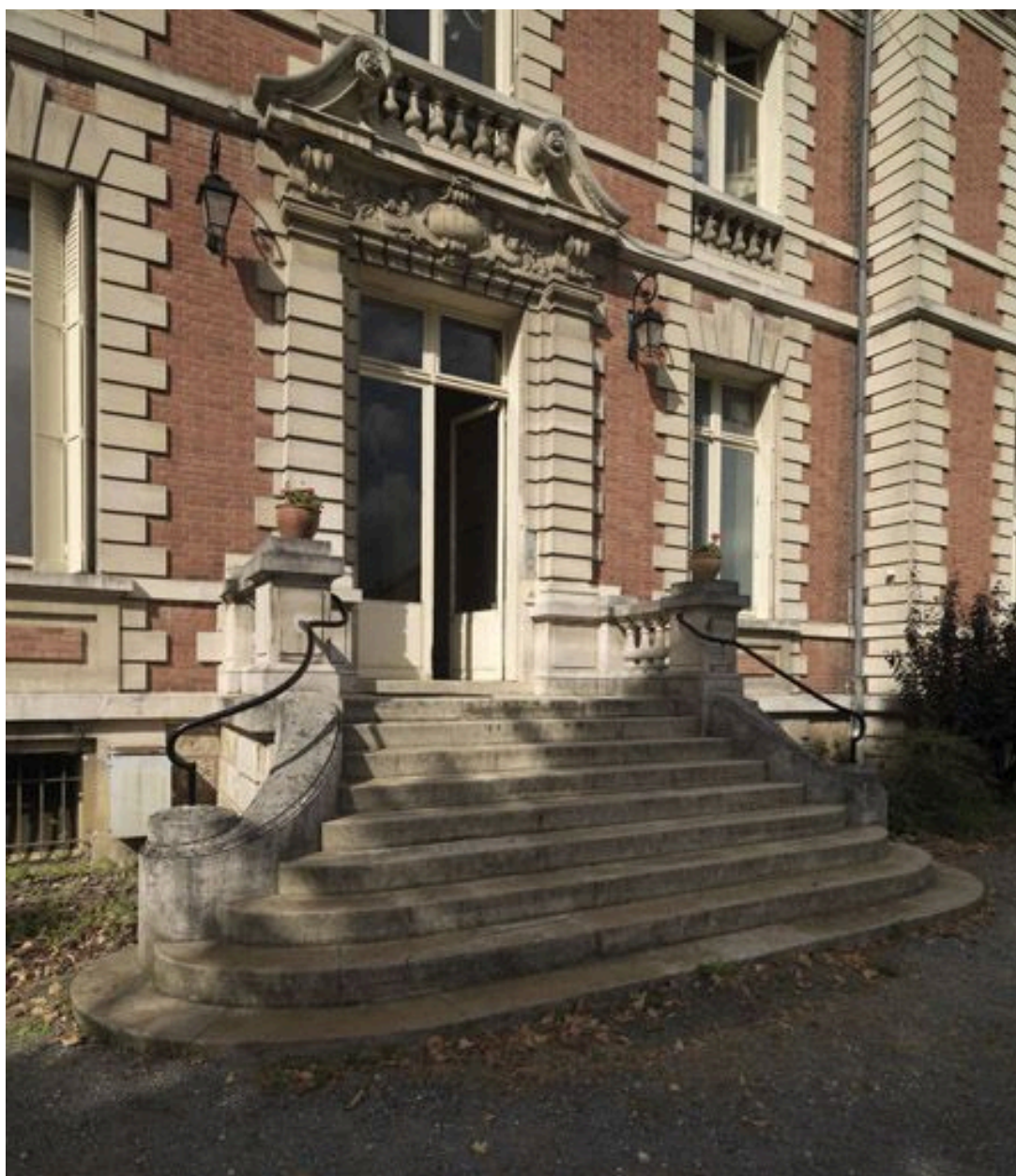
Détail du perron et de la porte d'entrée.
