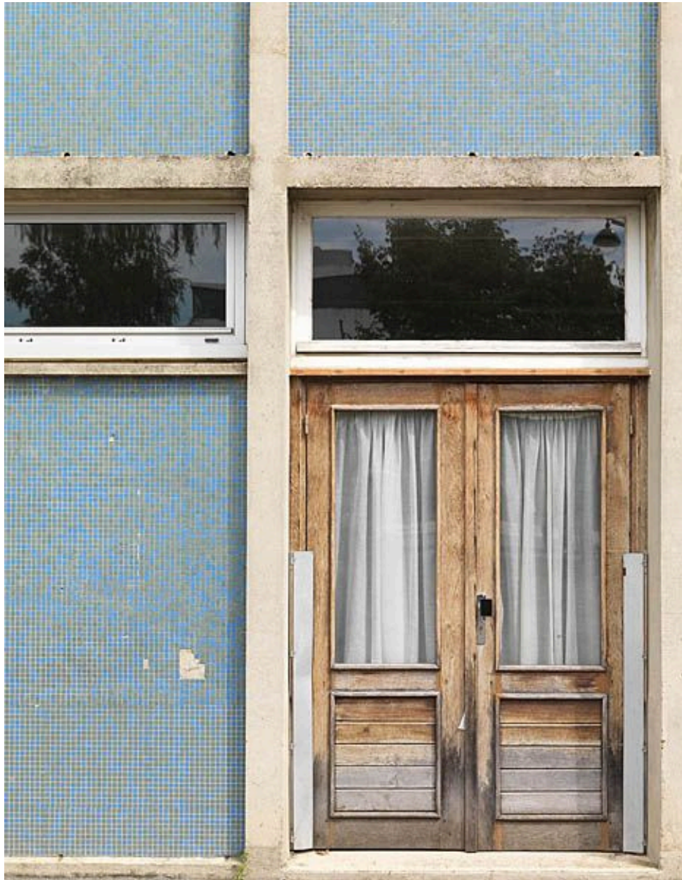
L'école du Pierris, 10 rue Guillaume-Briçonnet (actuellement centre aéré). Façade avant. Détail de la mise en oeuvre des pâtes de verre et de la porte.
