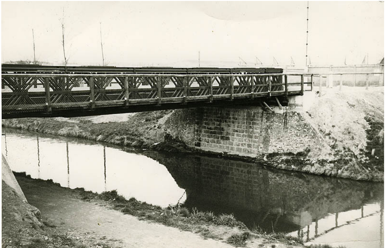
Ancien pont enjambant le canal de l'Ourq et reliant les quartier de la Pierre-Collinet à Beauval. (Collection particulière)
