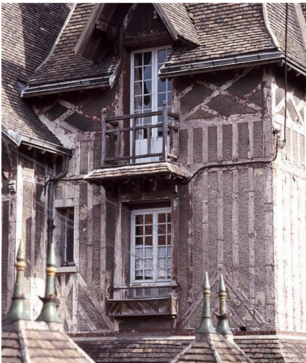
Détail d'une travée d'une maison, 19 rue Victor Basch.
