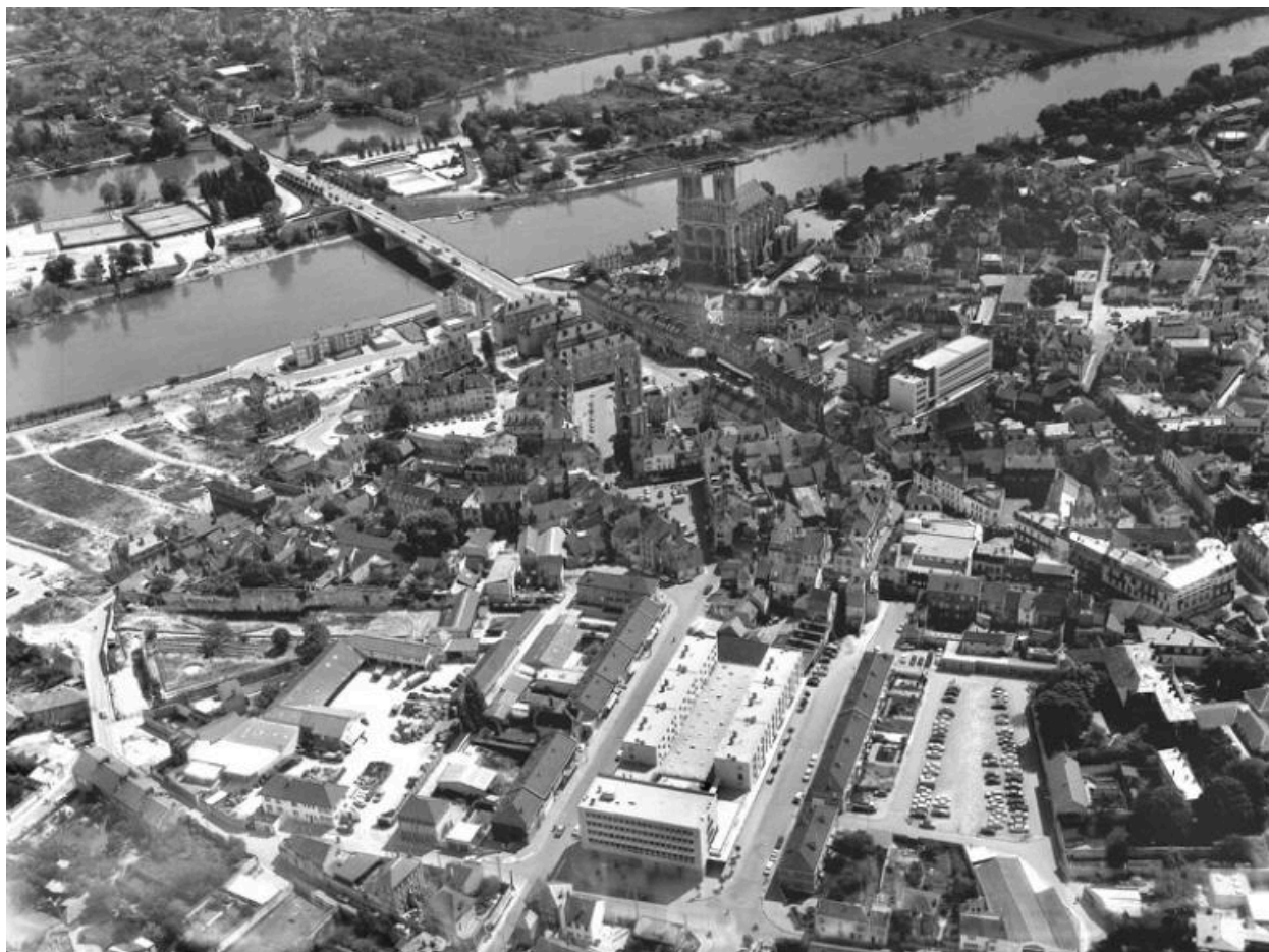
Les bas quartiers en cours de destruction. (Fonds Bertin).
