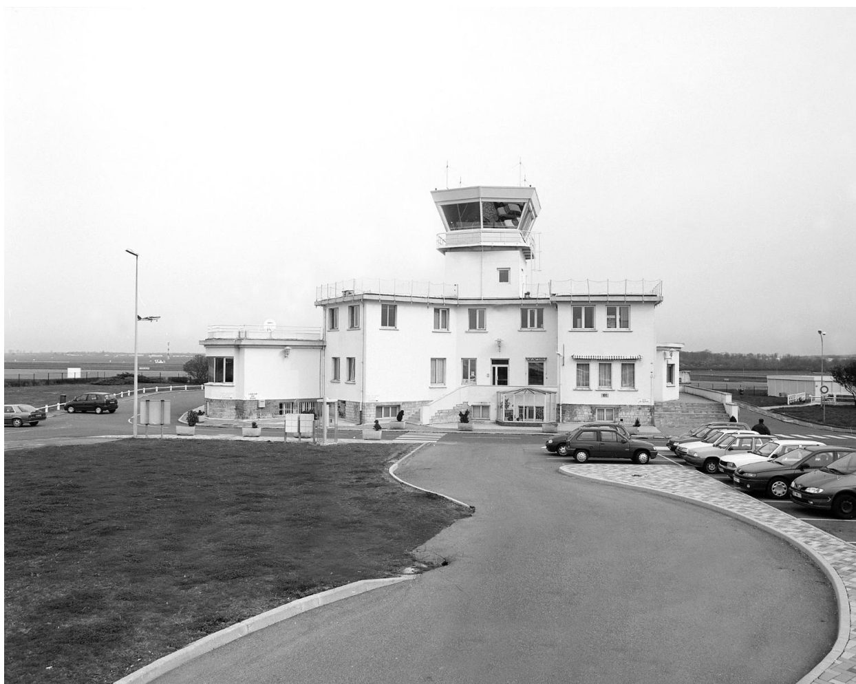
Vue de la tour de contrôle récemment modifiée.
