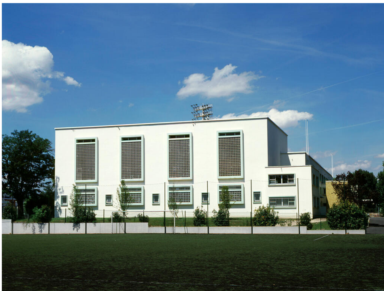
Vue de la façade du Palais des Sports. Stade Auguste Delaune
