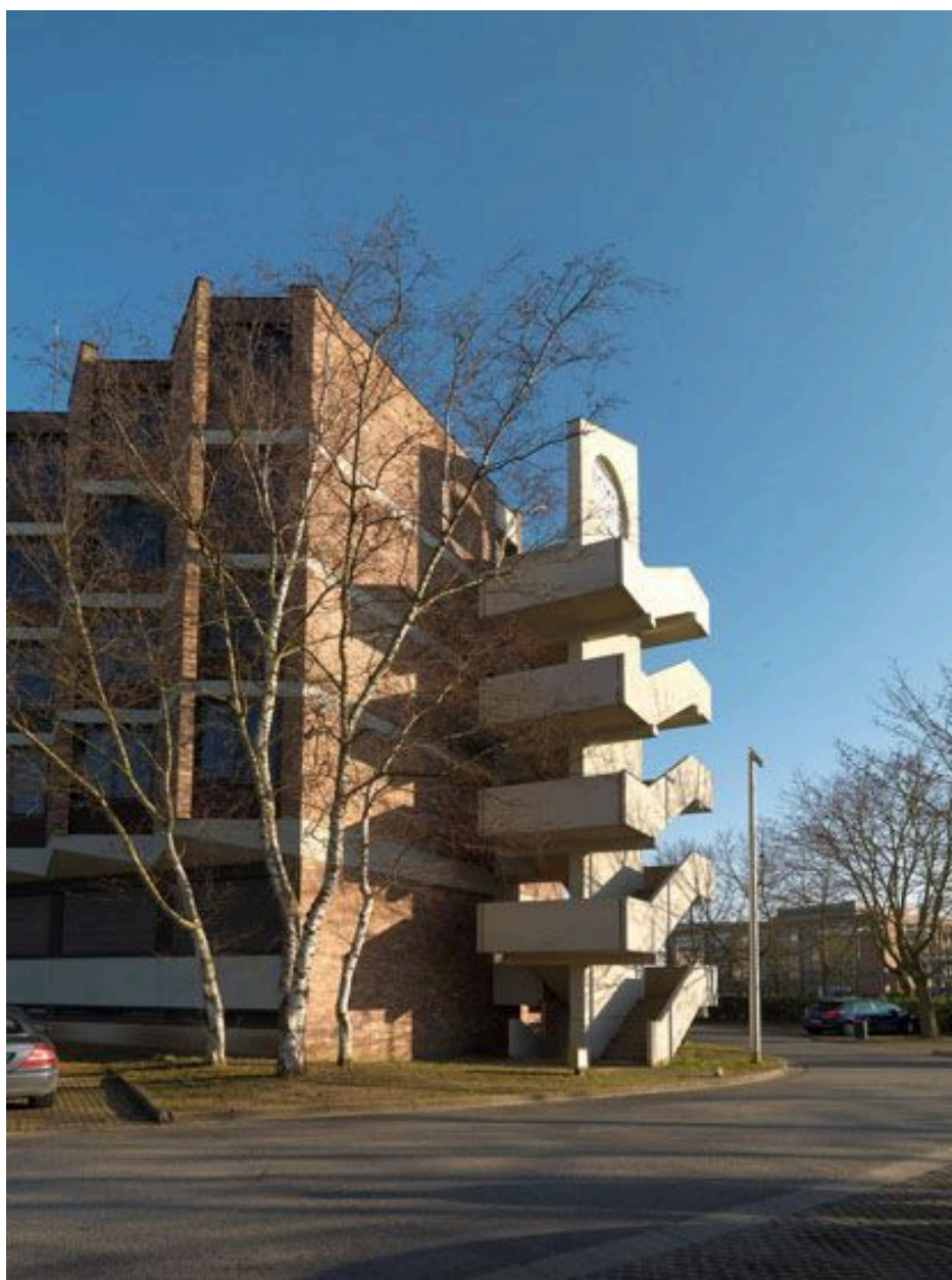
Vue de l'escalier de secours extérieur.
