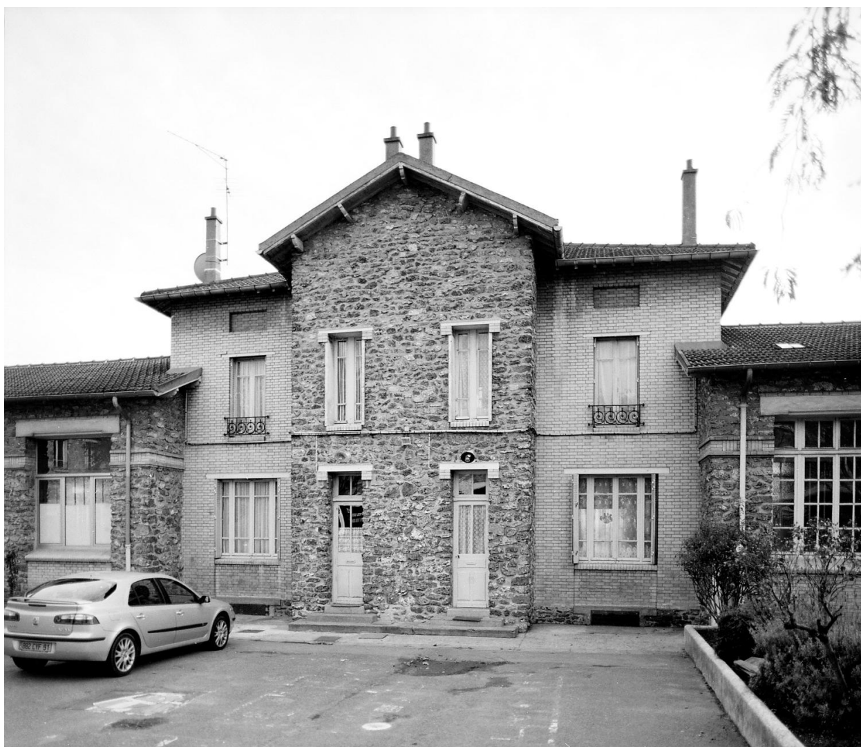
Vue côté cour du logement des instituteurs.
