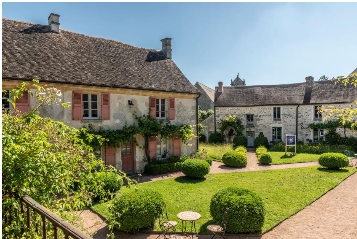
Vue générale depuis le sud-ouest.
