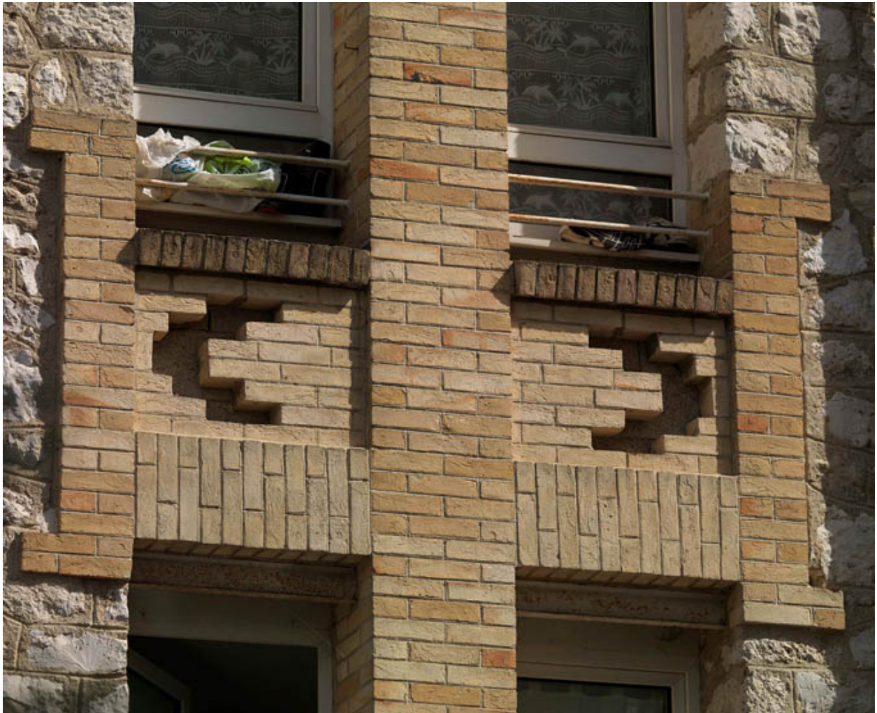
Immeuble rue Pasteur. Garde manger reprenant les deux "C" du monogramme de la Société immobilière de Champagne.
