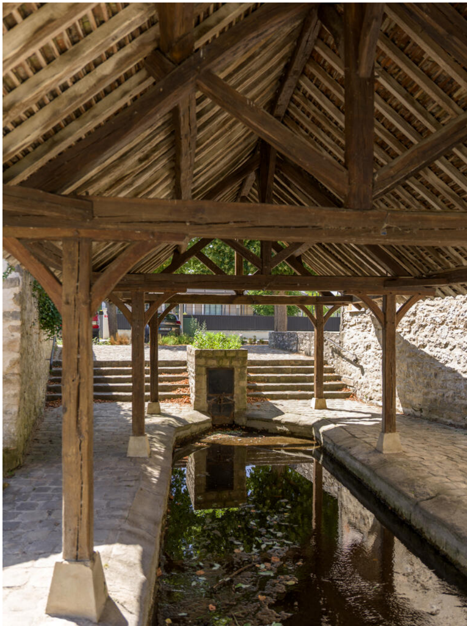
Vue de la charpente traditionnelle depuis l'est.
