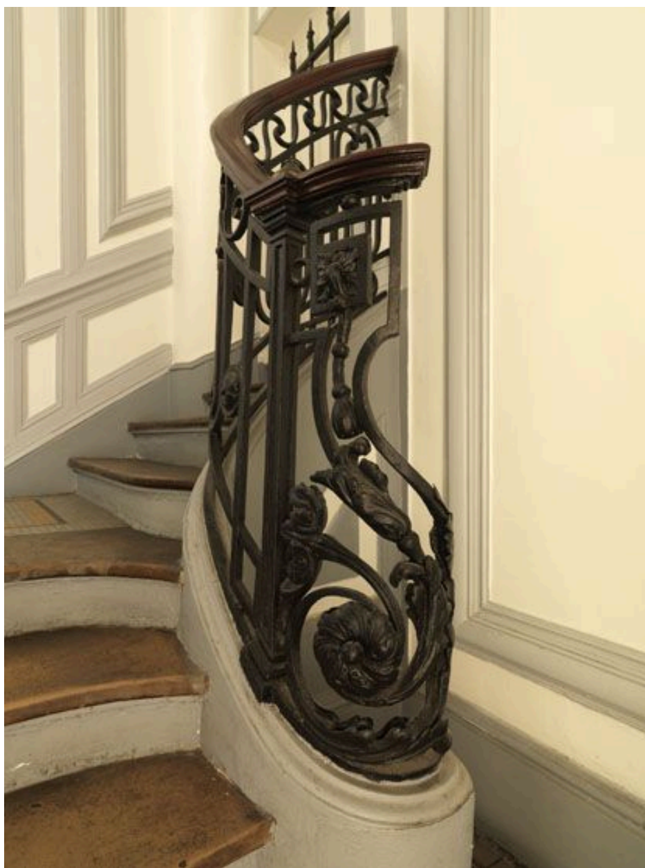
La console de départ de l'escalier.
