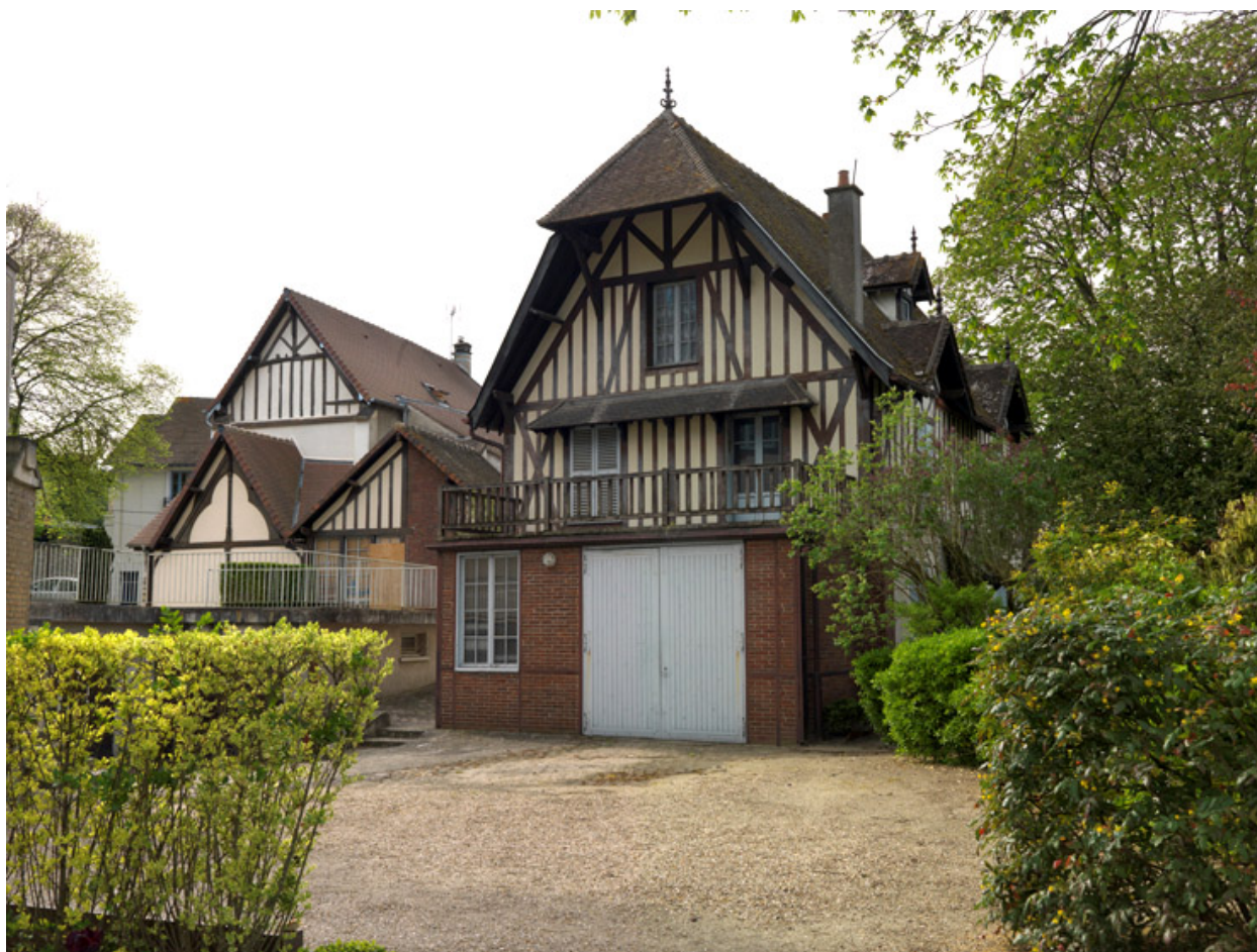
Vue du pignon de la seconde maison avec sa demi-croupe largement débordante.
